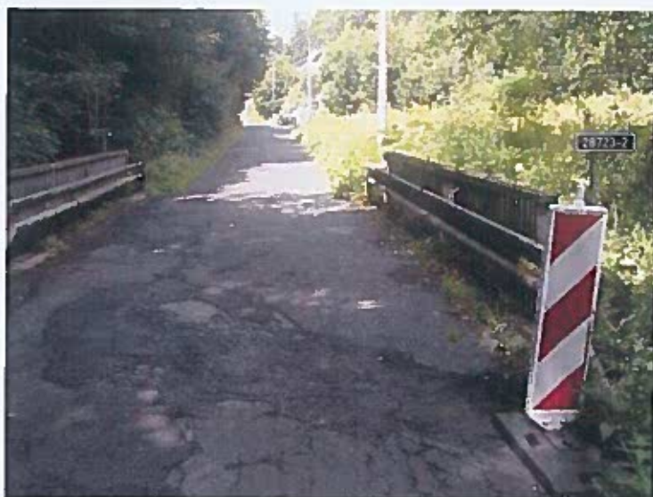
Pohled na most po směru staničení
