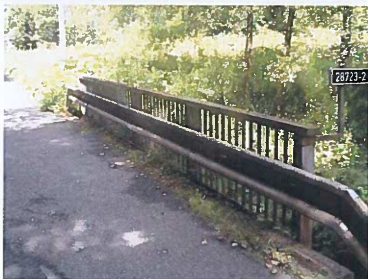
Pravé zábradelní svodidlo
