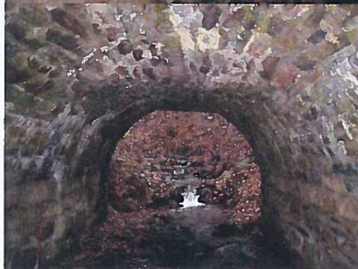
Pohled do vrcholu klenby od výtoku
