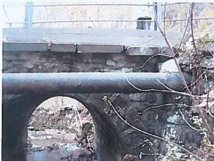
Pohled na pravé křídlo na vtoku
