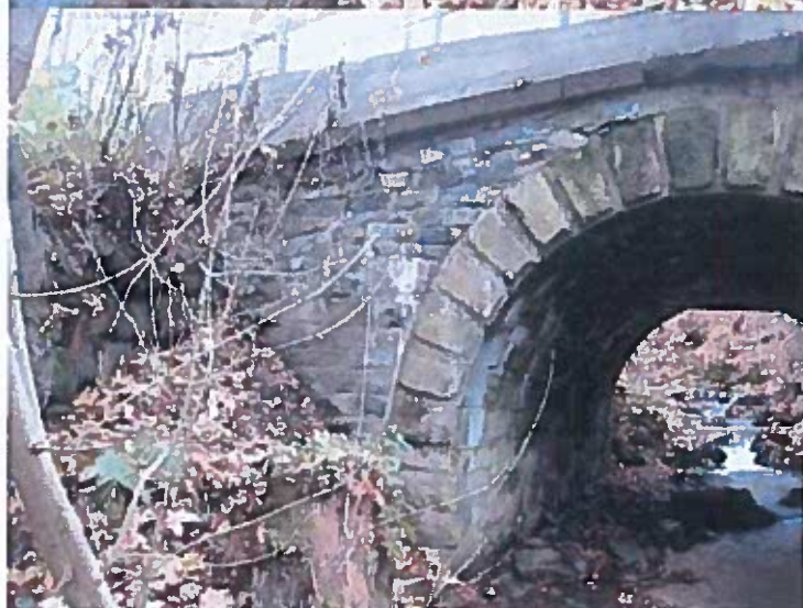
Pohled na levé křídlo na výtoku
