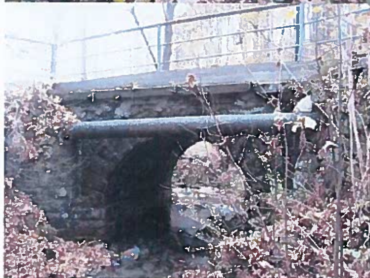
Pohled na čelo na vtoku
